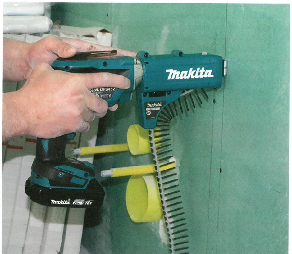
gewährleistet, dass die Schrauben in der gleichen Tiefe gesetzt werden. Die Schraubplatte aus weichem Kunststoff vermeidet beim Aufsetzen ein unbeabsichtigtes Abrutschen und das Beschädigen der Oberfläche. Die gegurteten Schrauben werden zudem kontrolliert geführt. Dies vermeidet unbeabsichtigte Beschädigungen an der Trockenbauplatte durch
